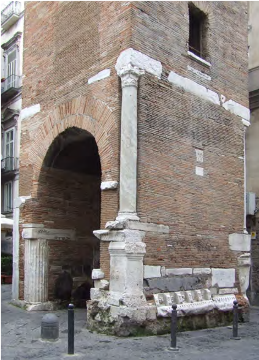
Figura 11. Campanile di Santa Maria Maggiore a Napoli in cui sono visibili gli elementi di spoglio inseriti nel basamento (foto B. de Divitiis).
