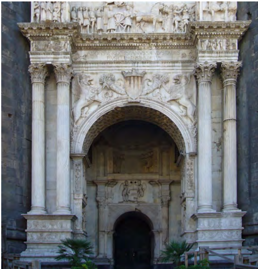
Figura 14. Particolare del fornice inferiore dell'Arco di Alfonso d'Aragona in Castelnuovo a Napoli (Francesco Laurana, XV secolo).
