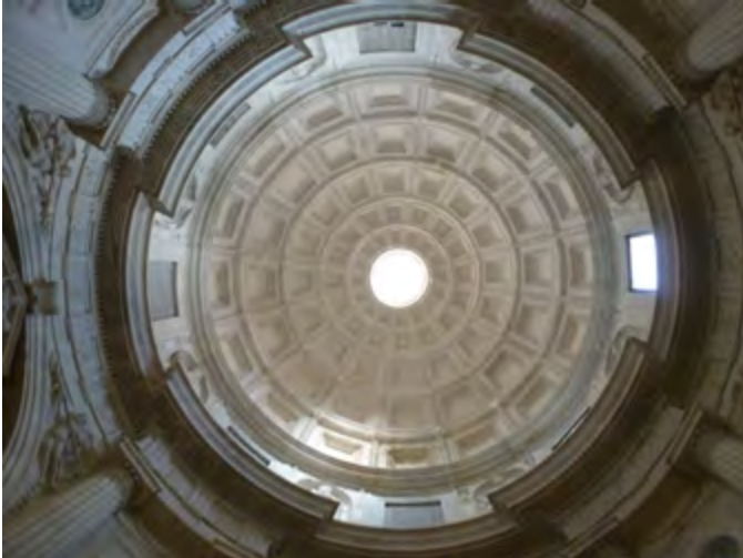
Figura 13. La cupola della Cappella Caracciolo di Vico in San Giovanni a Carbonara a Napoli (inizi XVI sec.) (foto B. de Divitiis).
