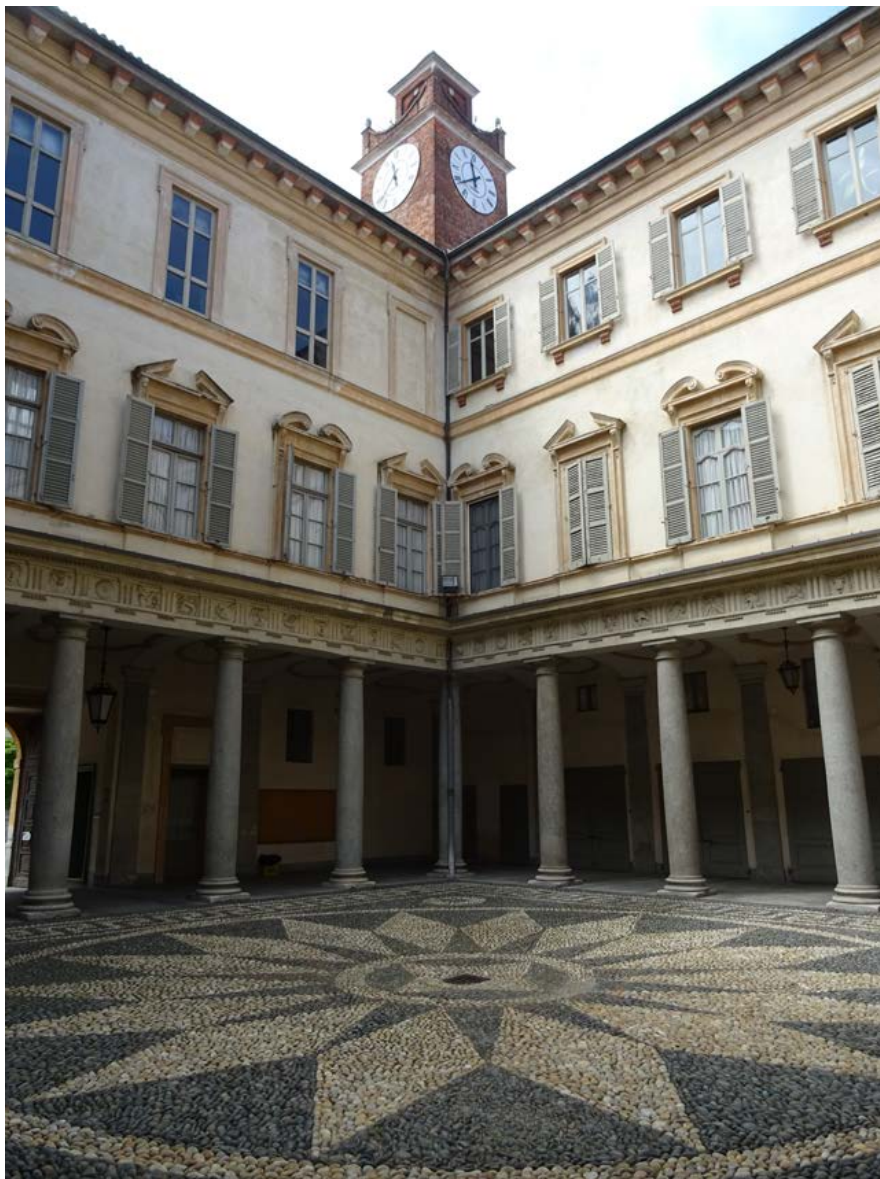
Figura 12. Novara, palazzo Casati, Caccia, Natta. Vista della corte, verso lo spigolo da cui si innalza la torre (foto S. Della Torre, 2020).
