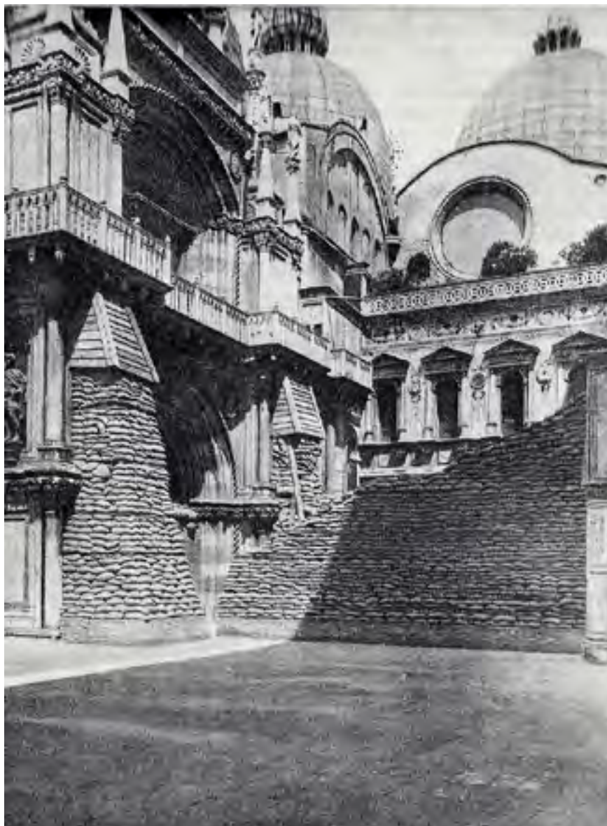
Figura 6. Venezia, opere di protezione al Palazzo Ducale (da OJETTI 1917, p. 64).
