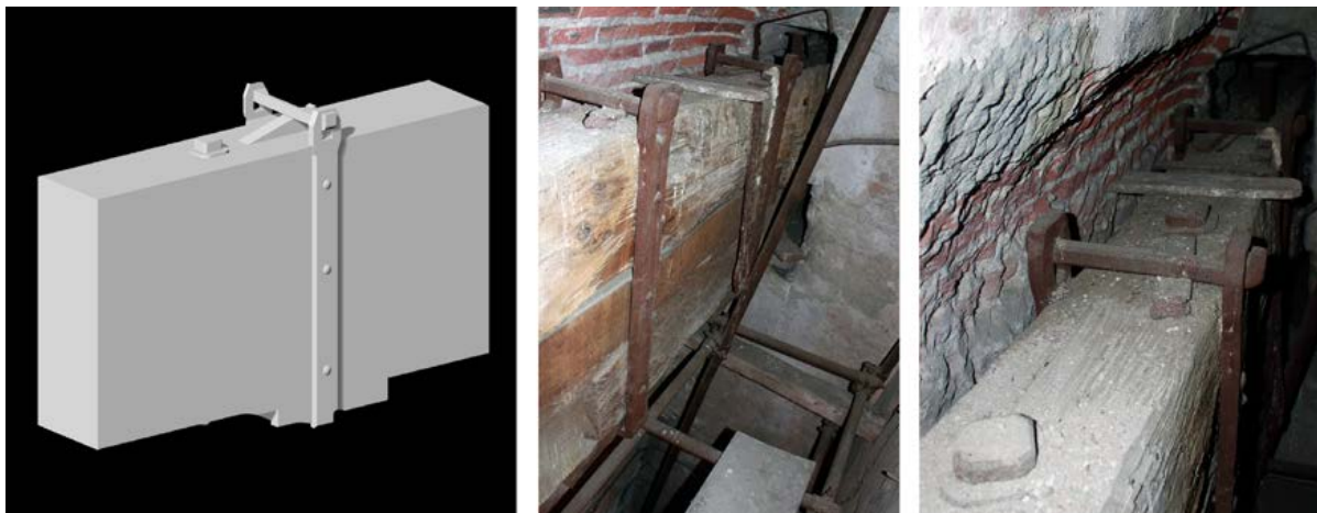
Figura 11a-c. Giunti di tipologia E: modello 3D e vano 17 (foto ed elaborazione S. Celli, F. Ottoni, 2018).
