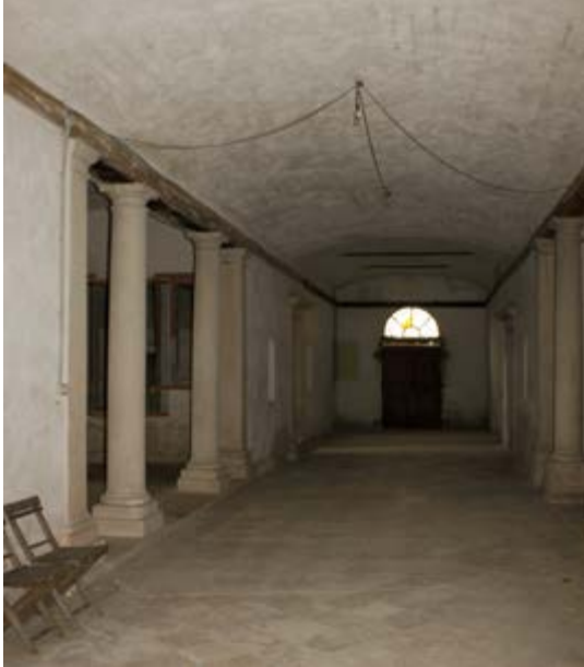
Figura 29. Canda (Rovigo). Villa Nani Mocenigo, galleria interna al piano terra. Le colonne sulla sinistra sono quelle da ricondurre al loggiato cinquecentesco rappresentato nell'Estimo del 1708 (foto V. Balboni, 2015).
