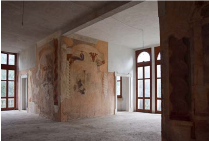
Figura 37. Canda (Rovigo). Villa Nani Mocenigo, veduta interna del primo piano, stato attuale (foto E. Montalti, 2018).
