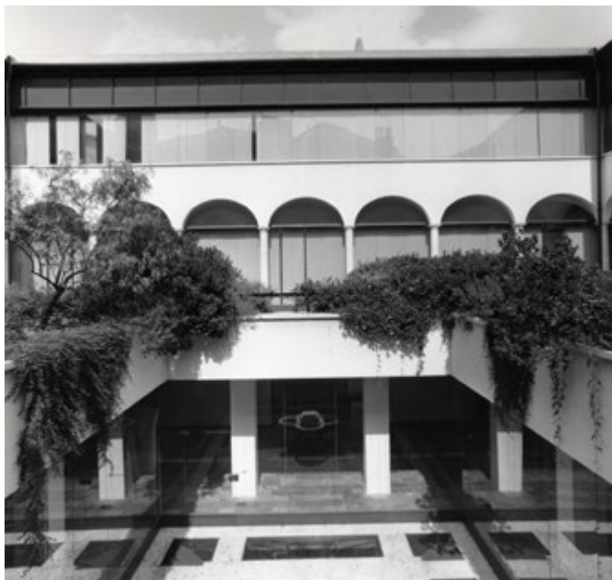
Nella pagina precedente, figura 11. Genova, complesso di Sant'Agostino, il chiostro quadrangolare durante il cantiere di restauro, anni Settanta (© Fondazione Franco Albini, Milano).
