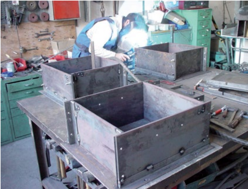
Figura 8. Costruzione di un elemento del muro della Haus Zivcec, foto. AAFFB.
