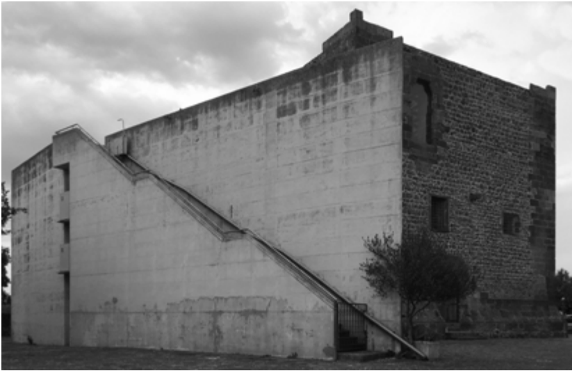
Figura 26. Ghilarza (OR), donjon aragonese, vista d'insieme ripresa da sud-ovest. In primo piano la scala inglobata all'interno del setto murario progettata da Cini Boeri (foto V. Pintus, 2019).
