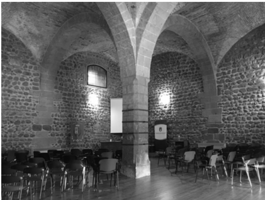
Figura 28. Ghilarza (OR), donjon aragonese, vista della sala al primo livello, allestita in funzione dello svolgimento di una delle tante iniziative accolte nell'antica struttura (foto V. Pintus, 2020).
