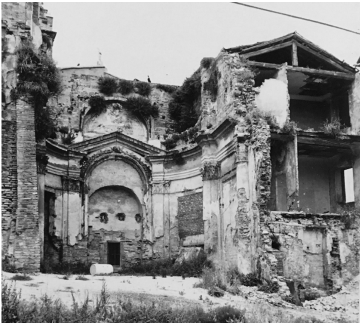
Figura 4. Ancona, Rione di Capodimonte, Progetto di Risanamento e ristrutturazione del centro storico. Fotografia del 1976 di un edificio storico crollato che evidenzia l'entità dei danni provocati dal sisma del 1972. APIUAV, Trincanato 3, Attività professionale, 1, 062, 5.
