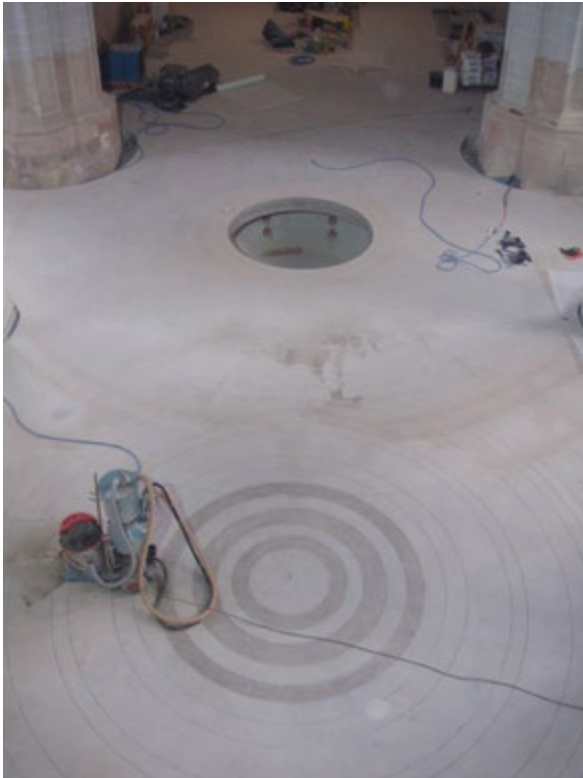
Figura 35. AFF, Zentrum Taufe St. Petri, Lutherstadt Eisleben, 2010-2012, fotografia di cantiere. AAFFB.
