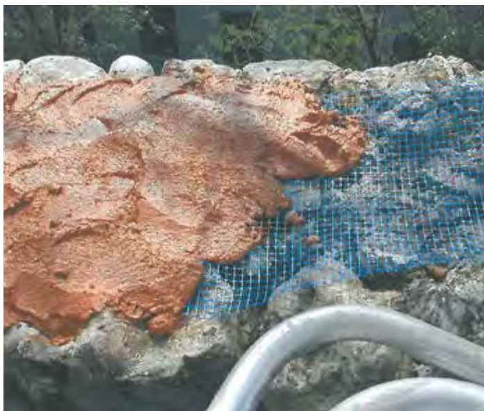
Figura 43. Puegnago del Garda, Brescia, stesura di copertina in cocciopesto (foto B. Scala).
