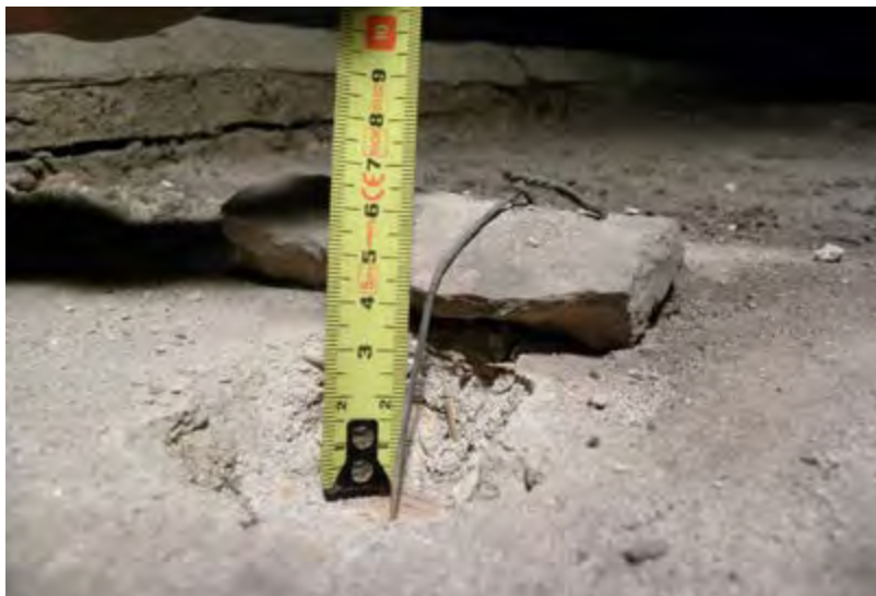
Figura 31. Legaccio in ferro a sostegno del controsoffitto in canne (foto A. Fontanini).
