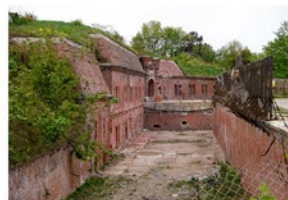
12. Fort IX - Thorn/Torun (Polonia) Stato di abbandono
