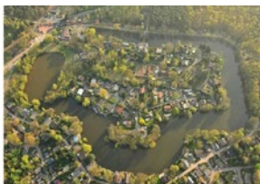
2. Fort Gravenwez- Antwerp (Belgio) Nuovo quartiere residenziale
