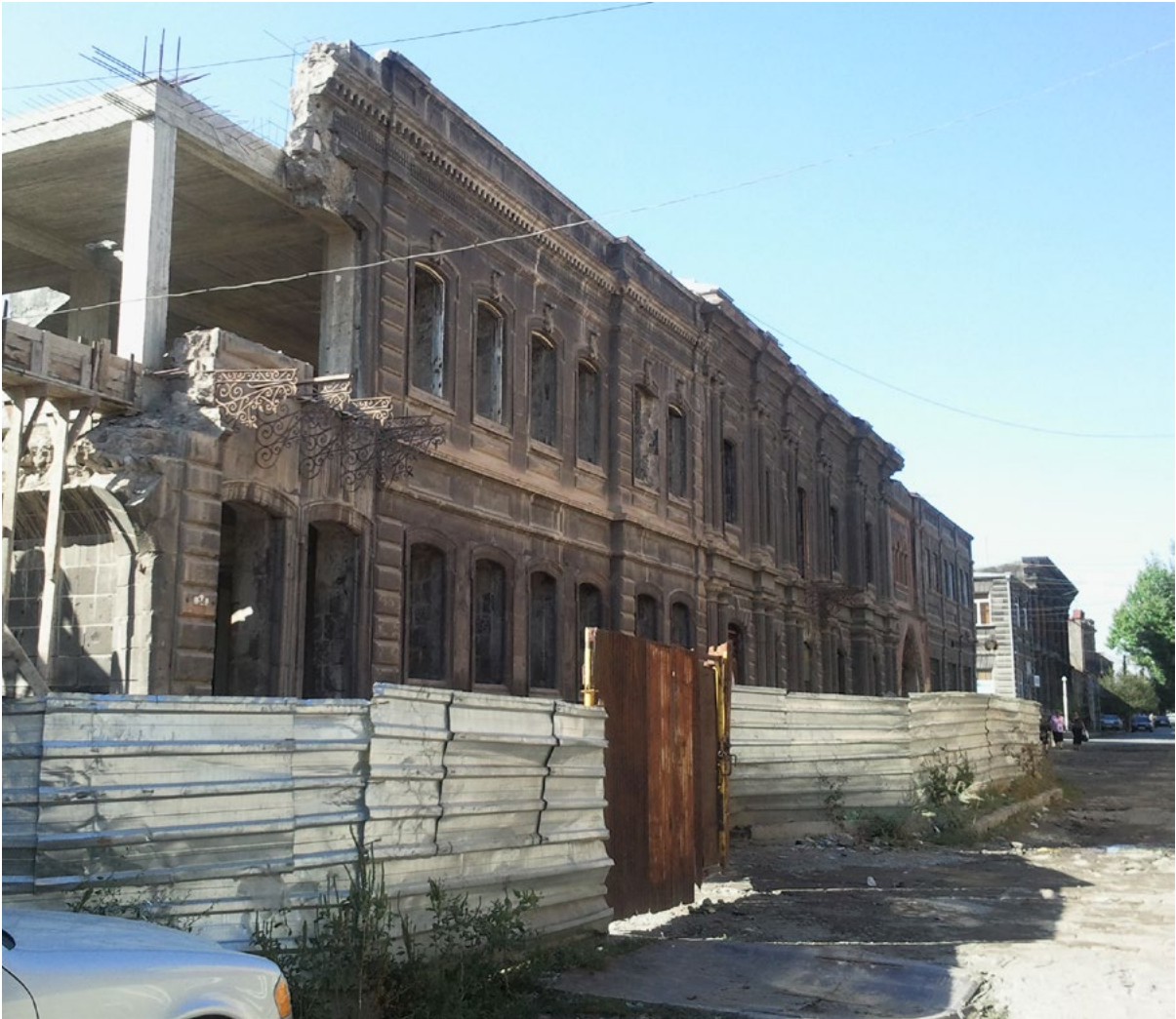
Figura 11. Gyumri (Armenia). Fronte di un edificio ottocentesco “montato” sulla nuova struttura in calcestruzzo armato (foto M. Giamb Bruno, 2019).
