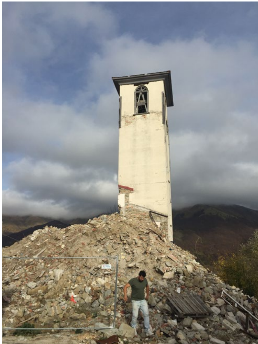
Figura 13. Campotosto (L'Aquila). Quel che resta della chiesa del paese, demolita nei mesi successivi al sisma (foto C. Bartolomucci, 2017).
