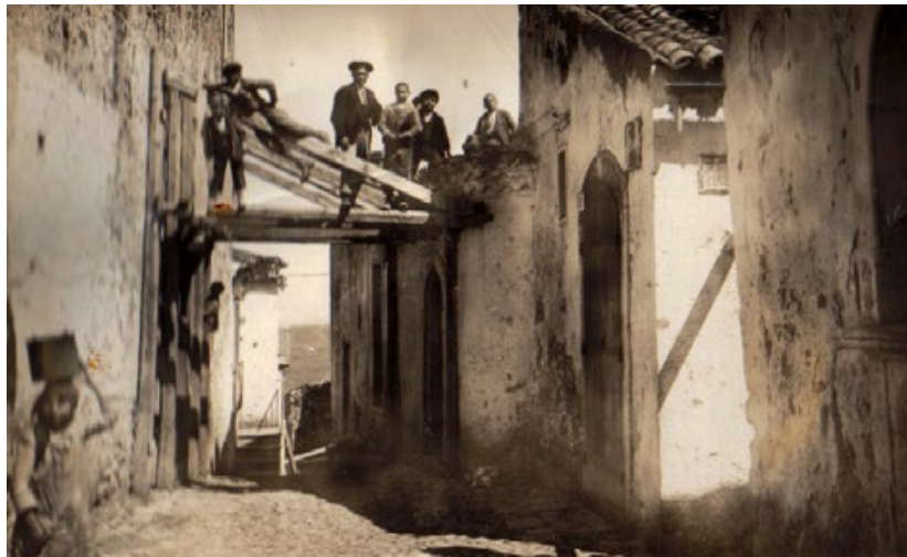
Figura 7. Foto d'epoca del centro storico di Accadia dopo il terremoto del 1930. Molte abitazioni seppur danneggiate sono in piedi ed è interessante come subito si provveda alla messa in sicurezza attraverso puntellamenti che si basano sugli stessi principi dei presidi sismici premoderni, quali archi di collegamento e speroni (da Comune di Accadia - Terremoto 1930, http://www.comune.accadia.fg.it/index.php?option=com_phocagallery&view=terremoto-1930&lang=it ) (ultimo accesso 28 marzo 2019).
