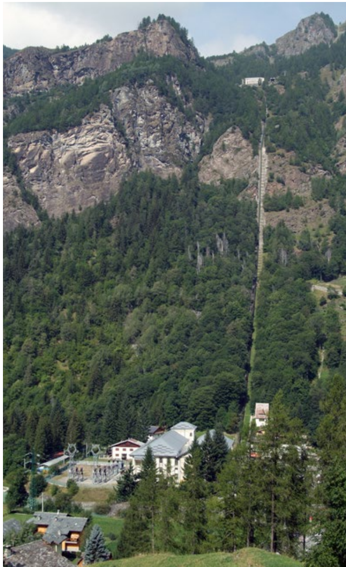
Figura 5. La cabina di pompaggio di Promeron in Valtournenche; in basso la Centrale di Maen (foto Studio Publica, 2017).
