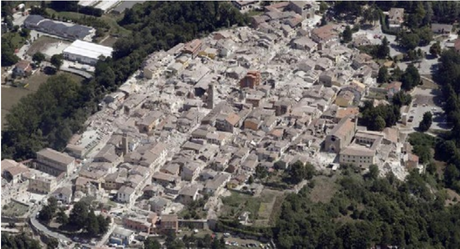
Figura 10. Amatrice (Rieti) dopo il terremoto del 24 agosto 2016, https://www.ilpost.it/2016/08/24/terremoto-amatrice-accumoli-foto-2/terremoto-amatrice-82/ (ultimo accesso 29 marzo 2019).
