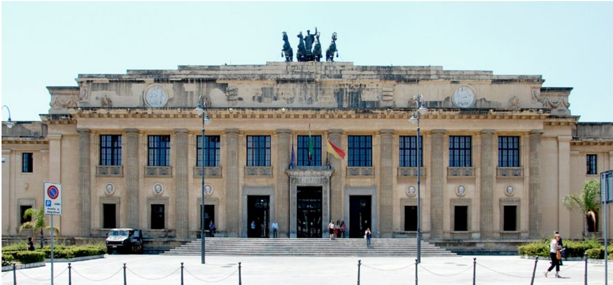
Figura 9. Messina. Palazzo di Giustizia, prospetto dell'edificio centrale (foto D. Sutera, 2015).
