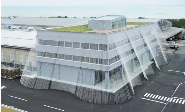
Figura 4. L'edificio della società Komatsu Seiren a Nomi, nella prefettura di Ishikawa, in Giappone, è la prima struttura di adeguamento sismico al mondo realizzata in fibra di carbonio ed è stata progettata dall'architetto giapponese Kengo Kuma, https://o.aolcdn.com/images/dims?quality=85&image_uri=http%3A%2F%2Fo.aolcdn.com%2Fhss%2Fstorage%2Fmidas%2Fba3ea58ffcebf92bc32db0113d45be1%2F203681121%2Fcabkoma-strand-rod.jpg&client=amp-blogside-v2&signature=58fae07d186b20f6743a2fd88abab18d3a824290 (ultimo accesso 12 febbraio 2019).
