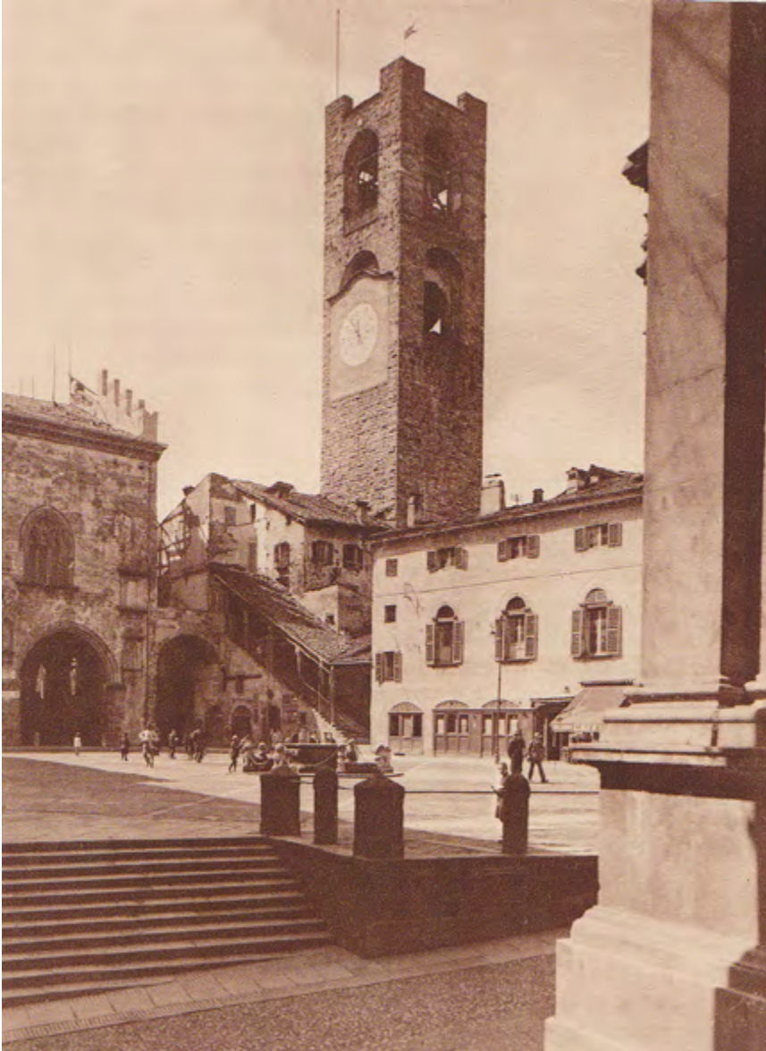
Figura 6. Bergamo antica, la torre della sede comunale e la piazza della fontana (PAPINI 1929, p. 10).
